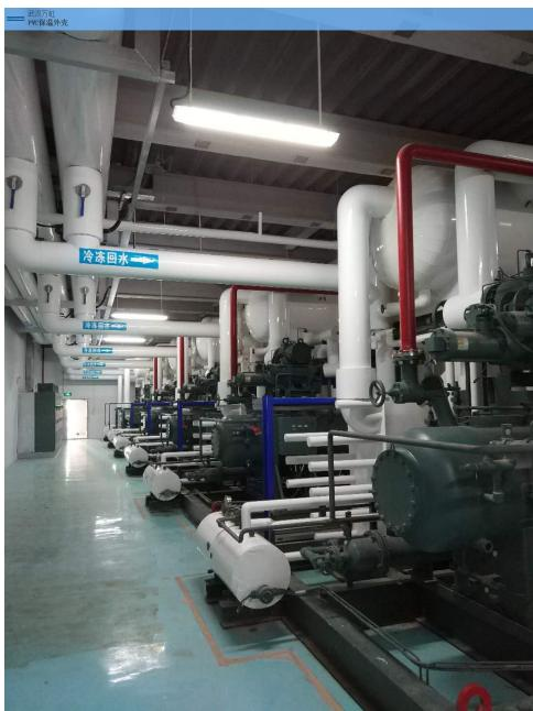
传统的保温外壳，是使用铁皮、铝皮等金属保温外壳，但是建筑、工业、民用、船舶等行业使用保温外护的目的就是为了节约能源，降低能耗，保温外护的使用寿命与以下这些因素有很大的关系。水或水蒸气为避免水或者水蒸气对高层建管道及设备的破坏，应选用憎水性好、水蒸气渗透性能好的保温外护，避免水或者水蒸气在迁移过程中出现保温层结露或保温层内部含水率增高的现象。而壳乐斯·彩壳PVC保温外护良好的封闭性可以抵抗避免水或者水蒸气对高层建管道及设备的破坏，从壳乐斯·彩壳PVC保温外护可以代替传统铝皮、不锈钢外护。内蒙古进口PVC彩壳哪个厂家质量好PVC保温外壳，厂家直接供货。
