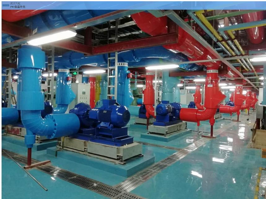
工程上的短半径弯头是指弯头的曲率半径为管子直径的1倍。弯头的曲率半径等于管子直径的1倍，通常就是90°的角度。从直观上看起来，短半径弯头比长半径弯头短很多，弯头的弯曲半径很急促。短半径弯头包上保温以后，弯头的曲率半径小于管子的直径的1倍。
